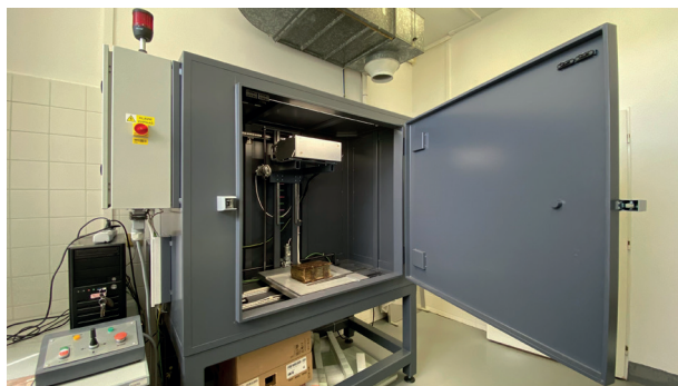
Obr. 3 Kabina s rentgenovým systémem
